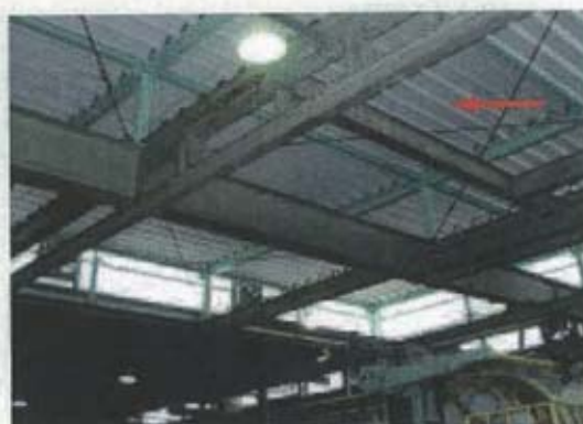
屋根用折版断熱材（折版屋根裏）
