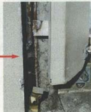
結露防止用の石綿含有パーミキュライト吹付け・パーライト 吹付け（天井・壁等の結露防止）
