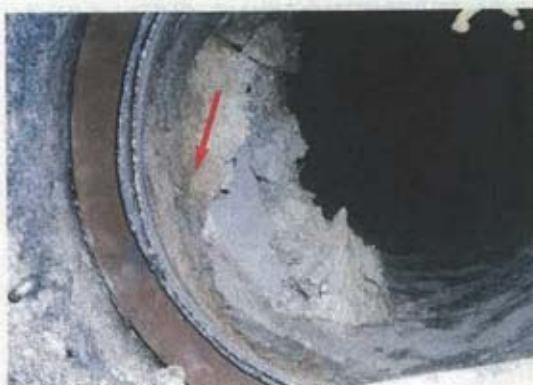
煙突断熱材（ライニング）
