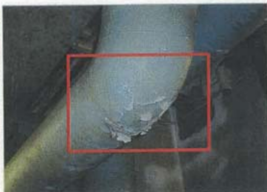
石棉含有保温材（配管曲がり部）
