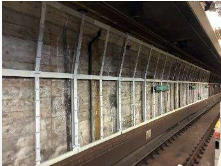
現況写真(ホーム対向壁改修)
