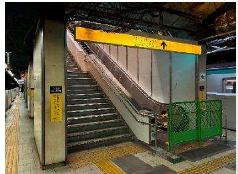
現況写真(ホーム階段改修)
