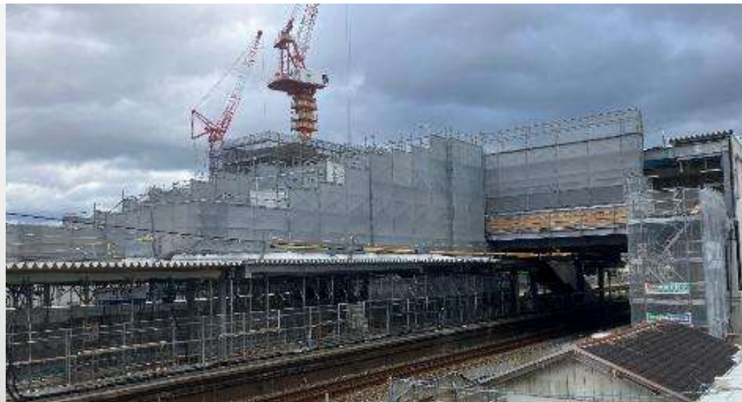
全 景（線路上空部）
