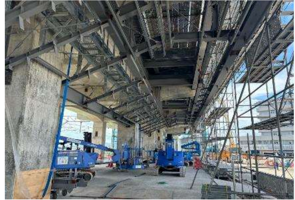
コンコース鉄骨工事
