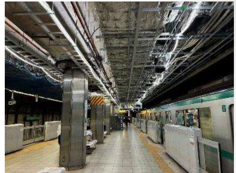
現況写真(ホーム天井改修)
